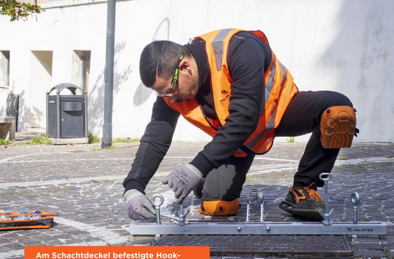
**Am Schachtdeckel befestigte Hook-Stange**
